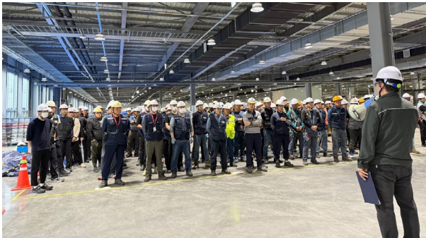
설비이전공사 밀착관리 현장
