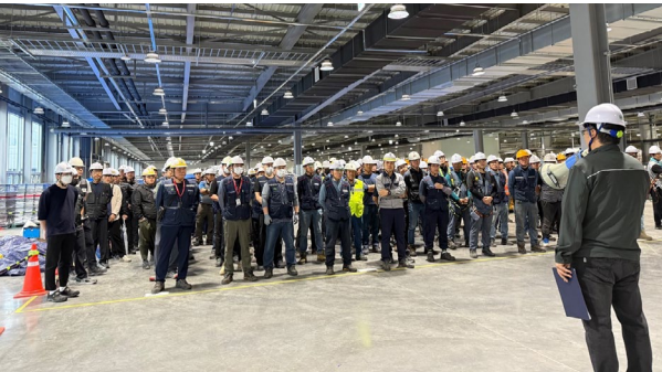
설비이전공사 밀착관리 현장
